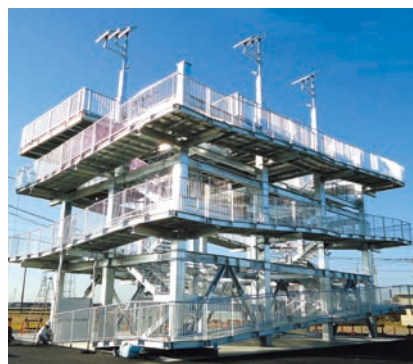
津波避難タワー
